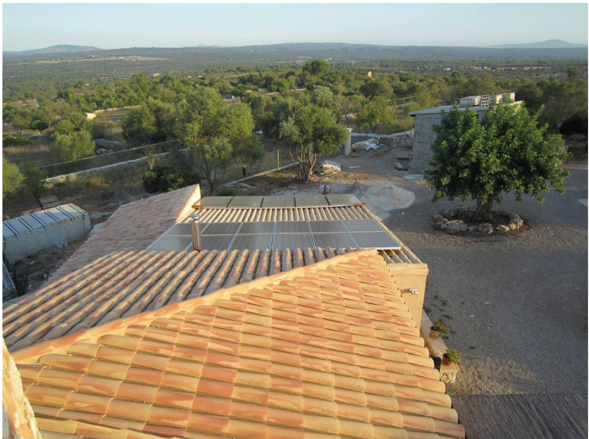
Solarzellen Strom (vorne) – Solarthermie Wasser (hinten)
