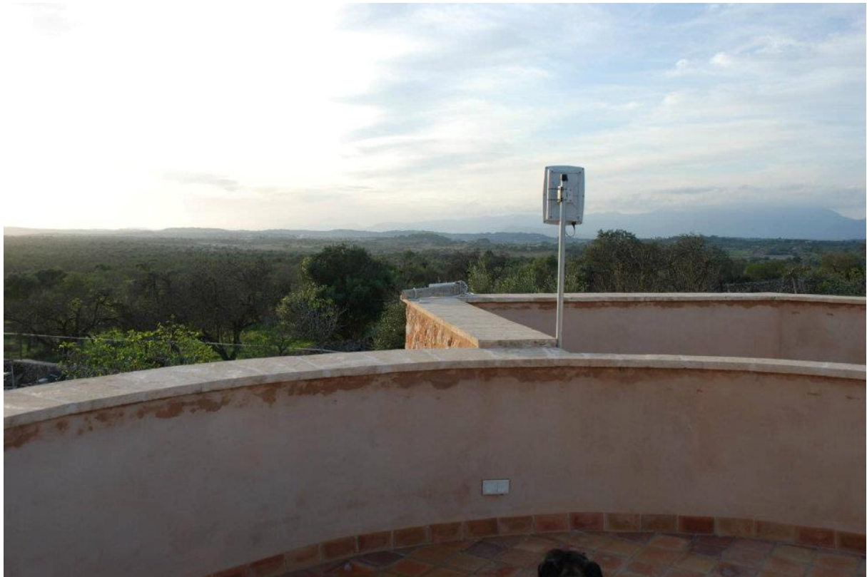
Richtfunkantenne für Internetanschluss und Telefonie (Richtung Palma)
