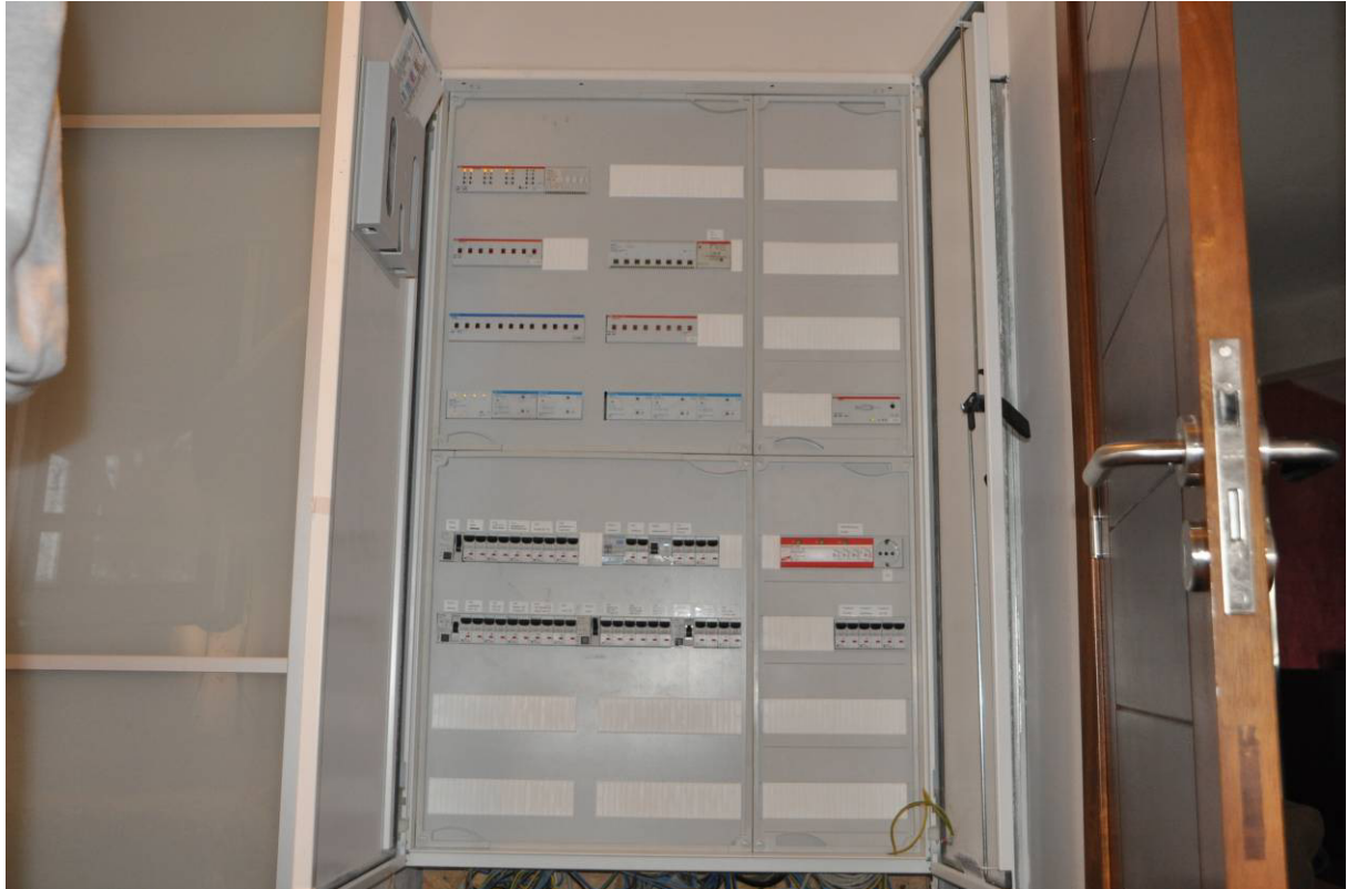
Elektroverteiler mit KNX-Geräten zur Gebäudeautomation
