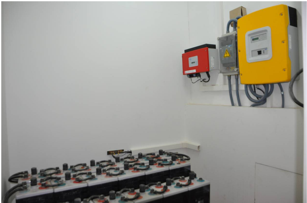
Solar-Akku-Anlage mit Speicher und Frequenzumrichter (Garage)
